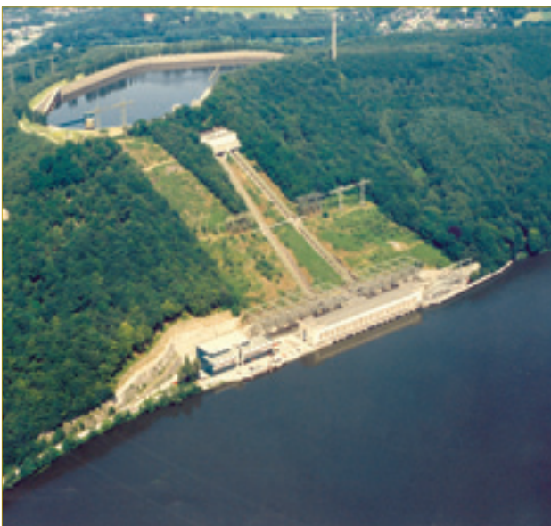
Energie aus Wasserkraft: das Pumpspeicherkraftwerk Koepchenwerk in Herdecke. (Abbildung: RWE/RWE Power)
