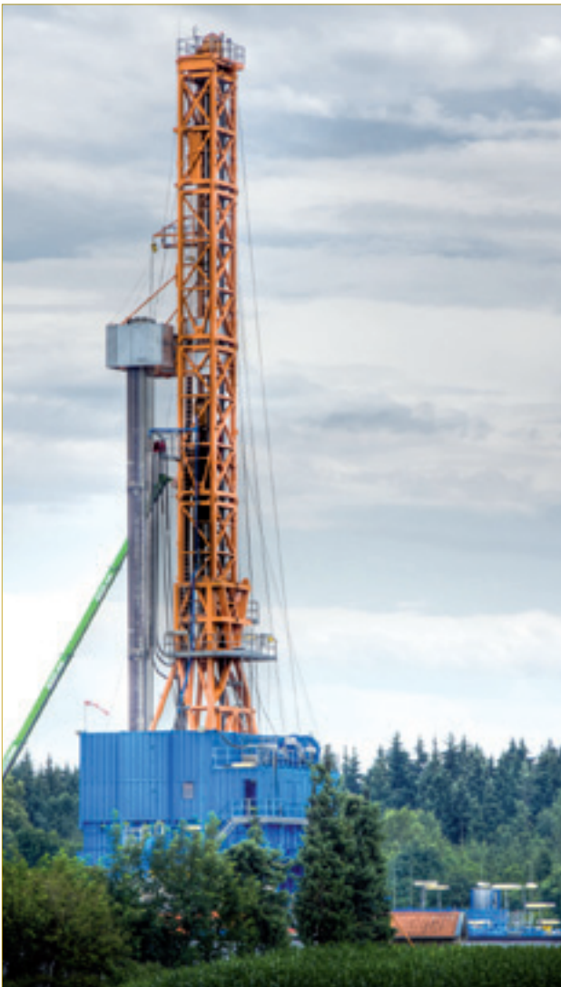
Tiefe Geothermiebohrung im bayrischen Taufkirchen: Da Erdwärme allzeit verfügbar ist, kann die Geothermie Engpässe bei der Gewinnung von Wind- und Sonnenenergie ausgleichen. (Foto: Daldrup & Söhne AG)
