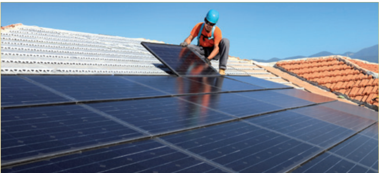
Installation von Solarmodulen: Die verstärkte Nutzung von Sonnenenergie ist der Schlüssel zur Energiewende. (Foto: il-fede, fotolia)
