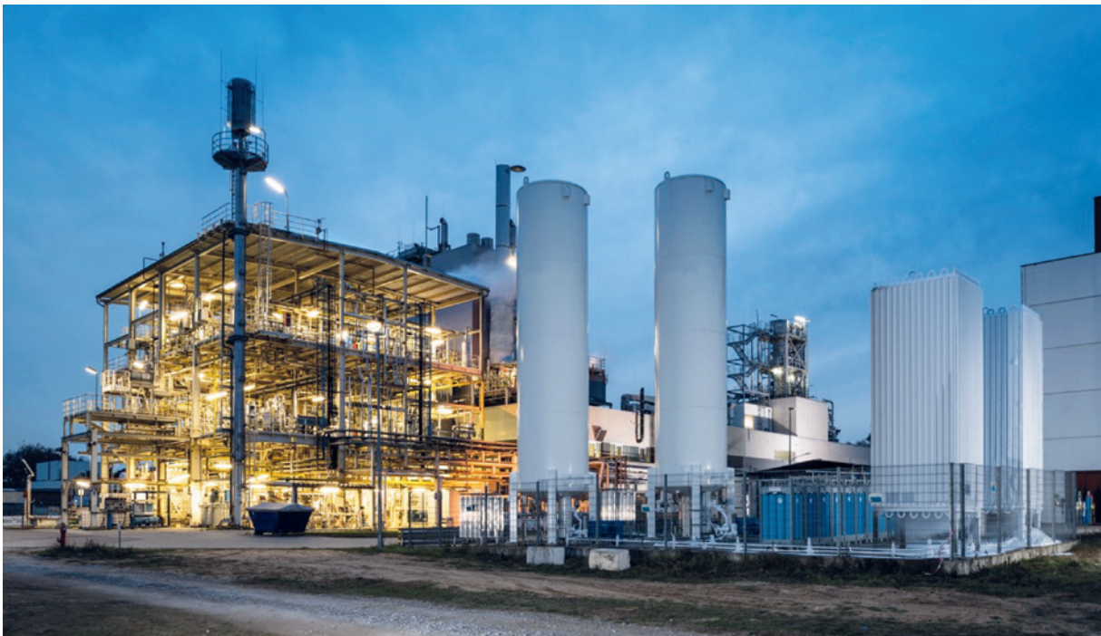
Abbildung 4: bioliq®-Anlage am Karlsruher Institut für Technologie zur Erzeugung von BTL (Biomass-to-Liquid)-Kraftstoffen über Synthesegas, DME und OME. (© KIT)
