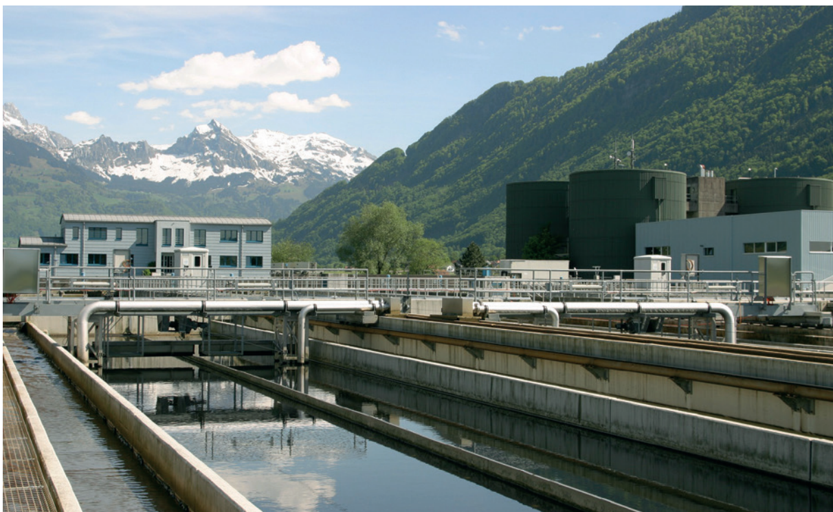
Abbildung 15: Klärwerk zur Abwasserreinigung. (© Pixabay / kubinger)
